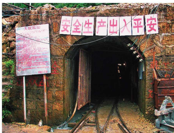
瑞土公司柴家营矿区 10# 洞采矿坑道
