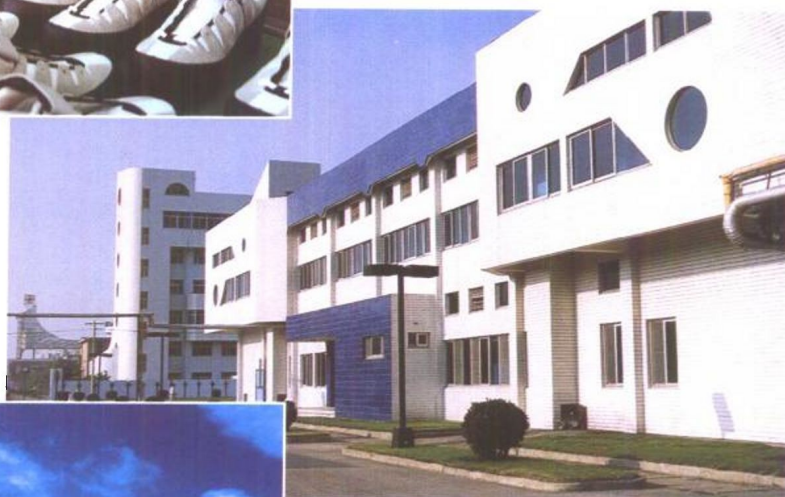
连云港正大天晴集团的针剂大楼
