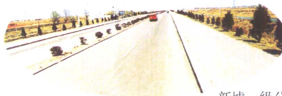
新墟一级公路
