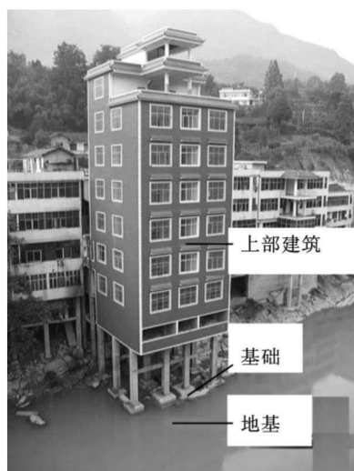
图 1-5 上部建筑、基础与地基
