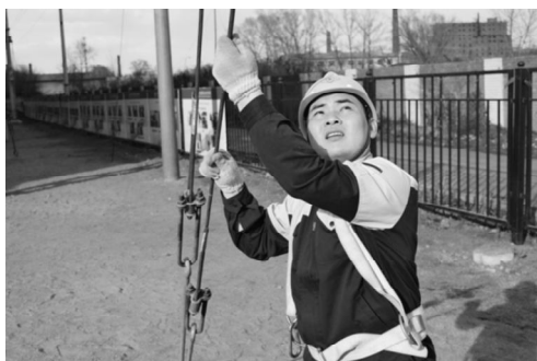
图 1.14 检查拉线状态
