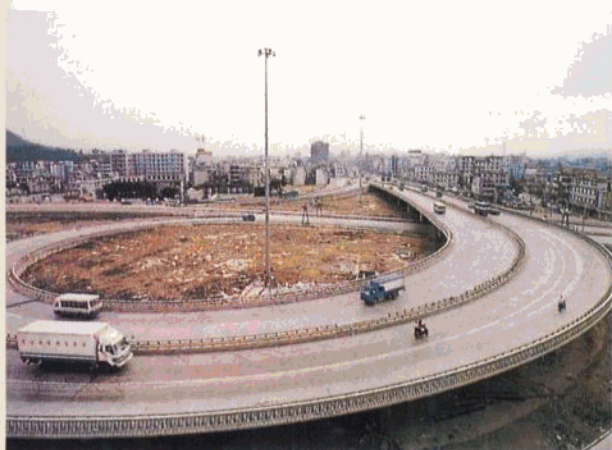
龍崗農行支持的龍崗立交橋、深惠公路擴建工程項目。
