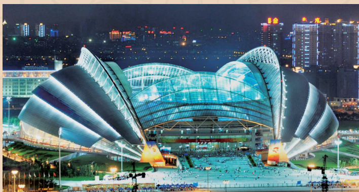
2007年竣工的浑南奥体中心
