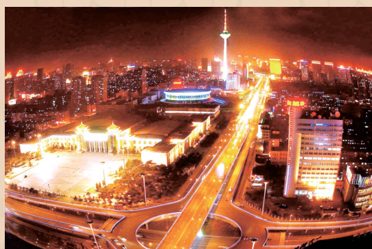
金廊沿线亮化工程（2006年）
