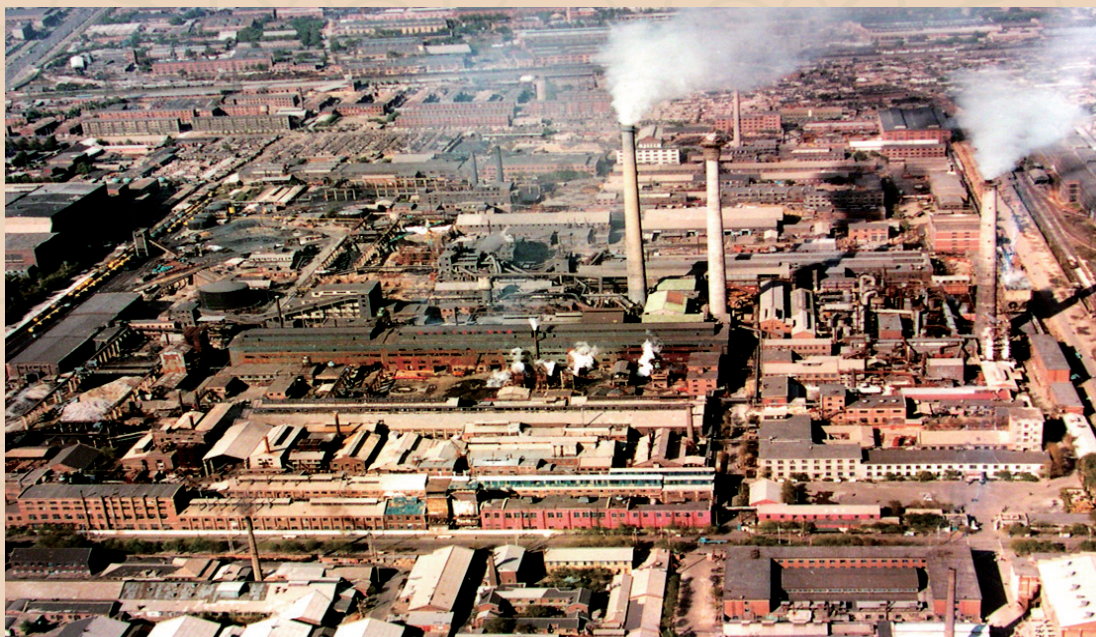
2004年3月25日，原沈阳冶炼厂三根百米大烟囱被爆破拆除
