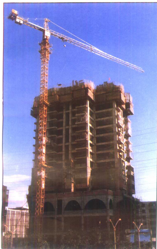
引进德国利勃海尔专有技术制造的60—120米的塔式起重机
