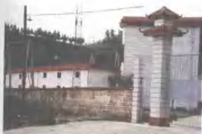
◀ 110KV 高峰变电站
