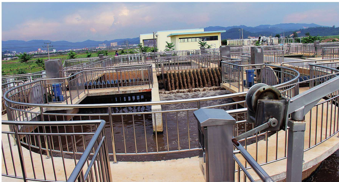
◎勐海县污水处理厂
