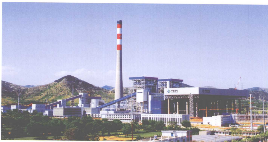
2007年7月24日,实现双投( 2 \times 600\text{MW} )的国电龙山发电公司全景。
