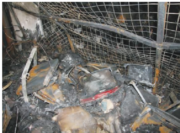
图9 二层商户摊位被烧毁的旧家电
