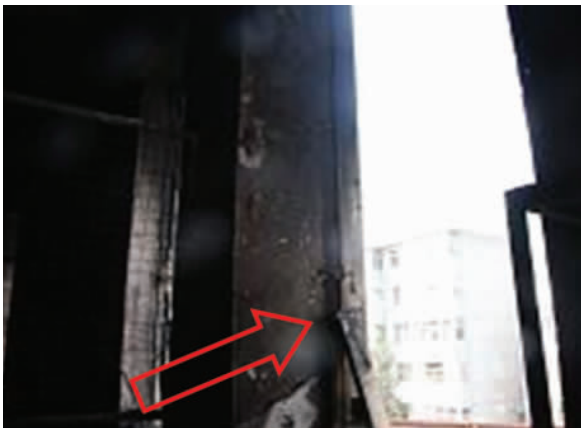
图 20 第四号商铺北侧窗户
