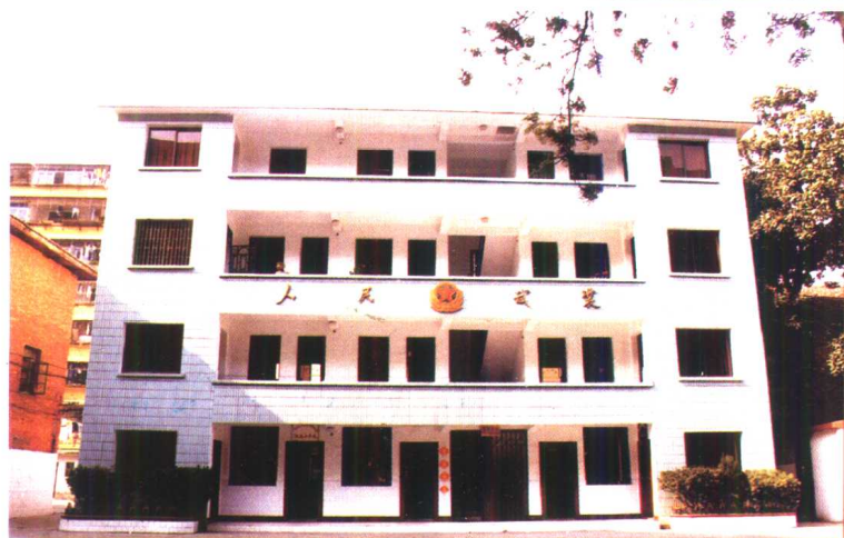
市人武部办公楼
