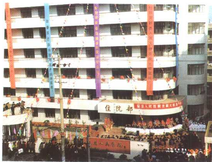
县人民医院住院楼
