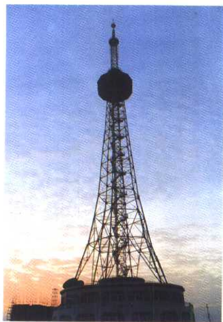
县电视台发射塔
