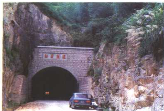
栢岭公路隧道
