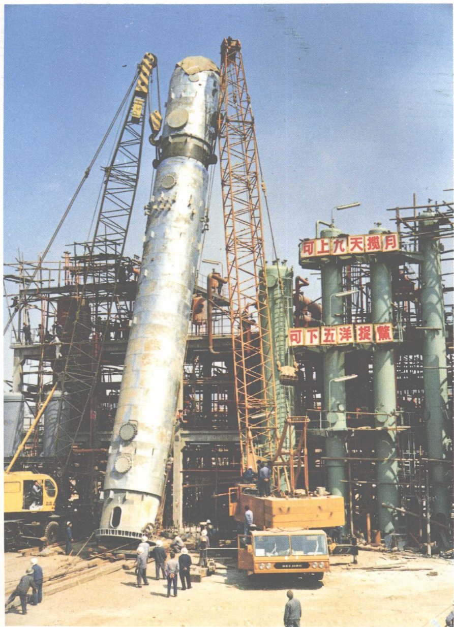
QD100 型100吨汽车起重机在化工厂工地作业。
