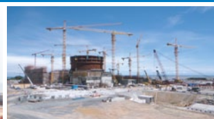
1号核岛安全壳第7层筒体砼浇筑完成
