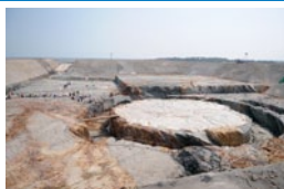
核岛负挖完成
