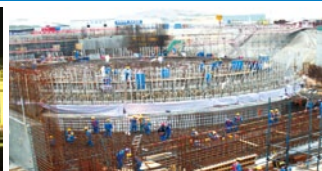
1号核岛完成筏基D层砼浇筑和养护
