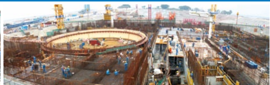
1号核岛钢衬里底板铺设焊接完成
