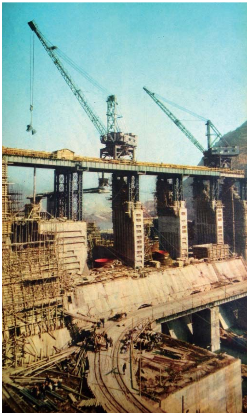
新安江水电站拦河坝一角 (1959)
