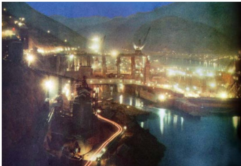
新安江水电站工地之夜 (1959)
