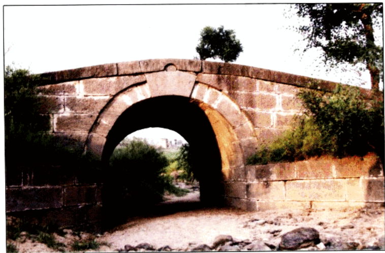
西口古道 通顺桥
