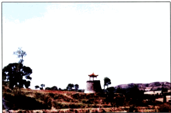
修复中的杀虎口长城闷楼
