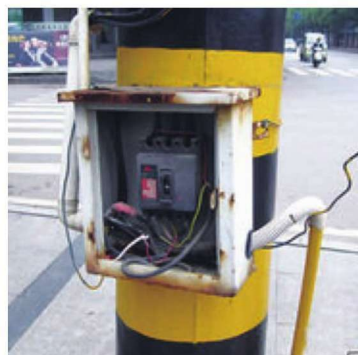
图 1-2-4 电线盒中裸露的电线头
