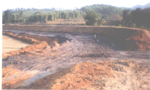
▶ 高要市多等上段内塘填沙固基。（照片由高要市水利局提供）
