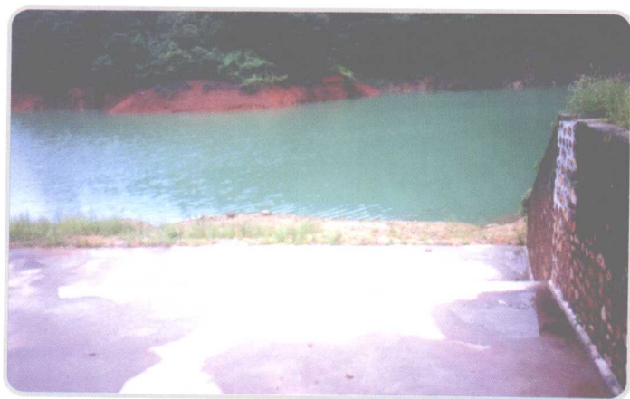
▲ 端州区维修后的欧田水库溢洪道新貌。 (照片由端州区水利局提供)
