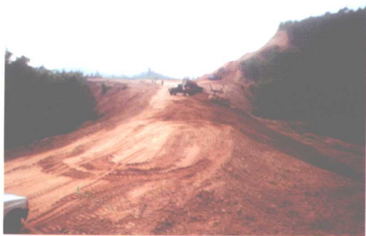
▶ 高要市多等上段内塘填沙固基。（照片由高要市水利局提供）
