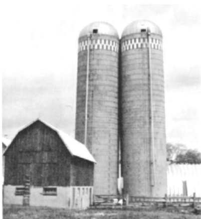
图 0-5 加拿大红河谷的两个饲料筒仓向内倾斜
