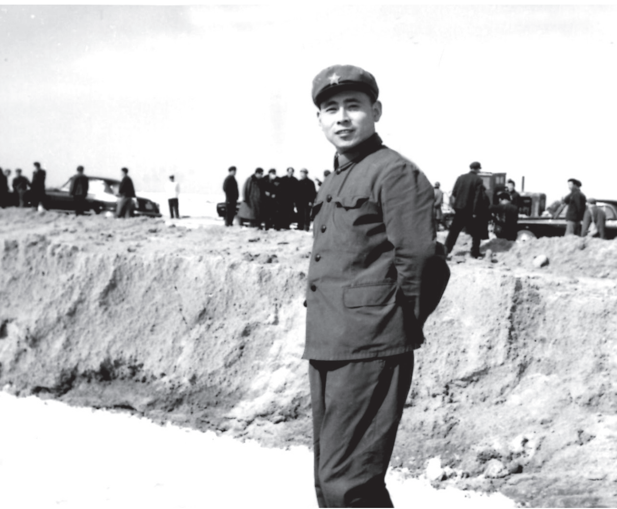
作者1977年于青藏铁路建设工地
