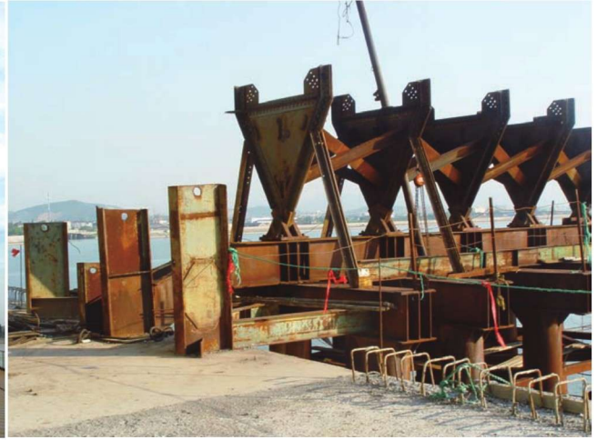
彩图11 搭设中的缆索吊装系统江中塔架
