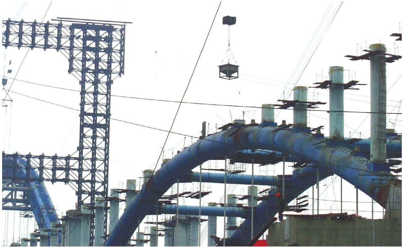
彩图19 灌注拱上立柱混凝土
