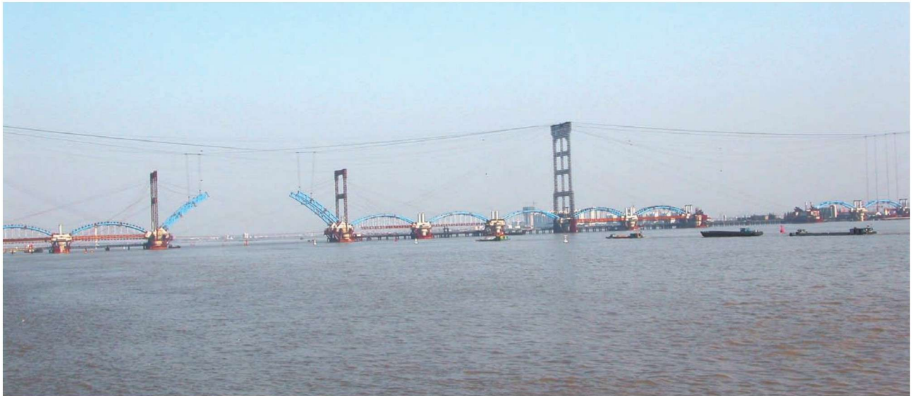
彩图10 缆索吊装系统
