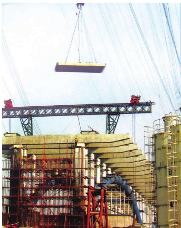
彩图24 安装85m跨桥面板
