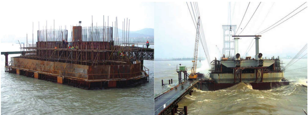
彩图7 墩身施工
