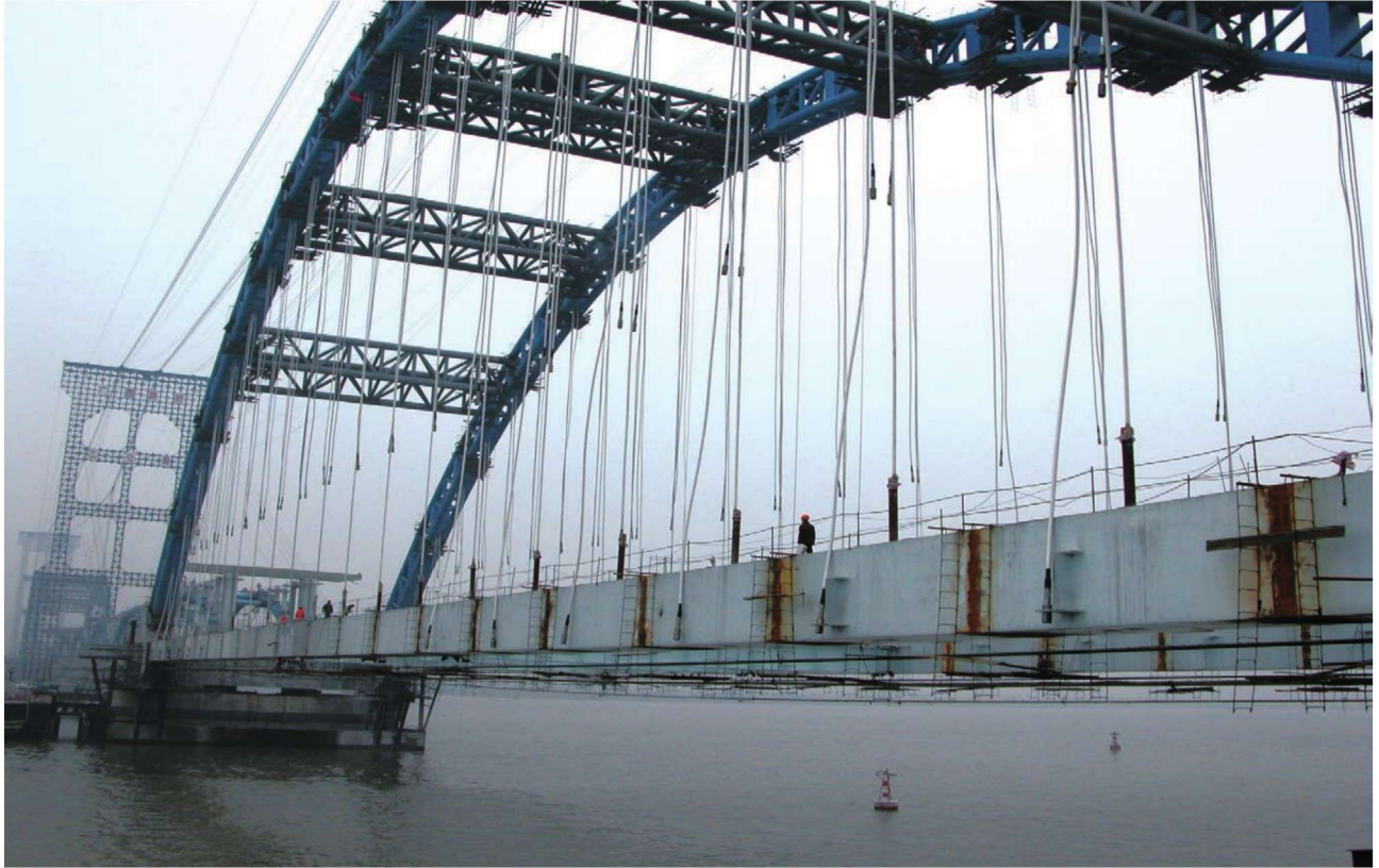
彩图31 施工190m跨钢系梁
