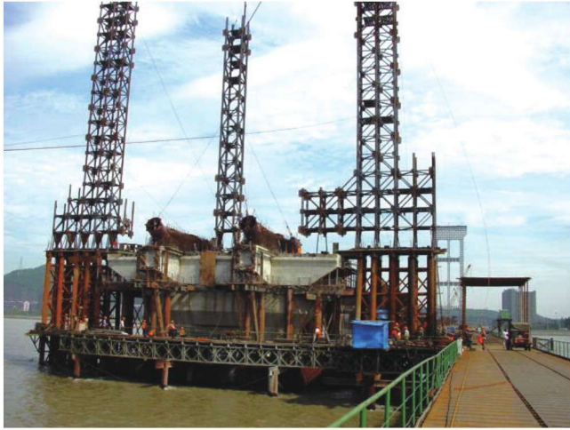
彩图11 搭设中的缆索吊装系统江中塔架
