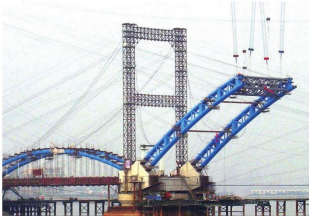
彩图28 安装190m跨拱肋风撑
