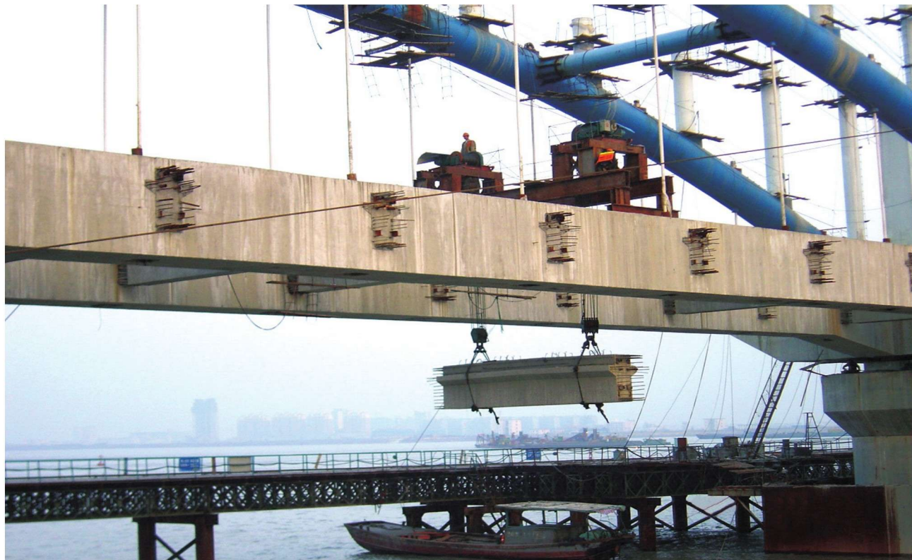
彩图21 安装85m跨系梁间横梁
