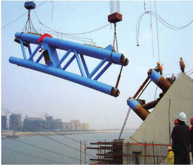
彩图26 安装190m跨拱肋节段
