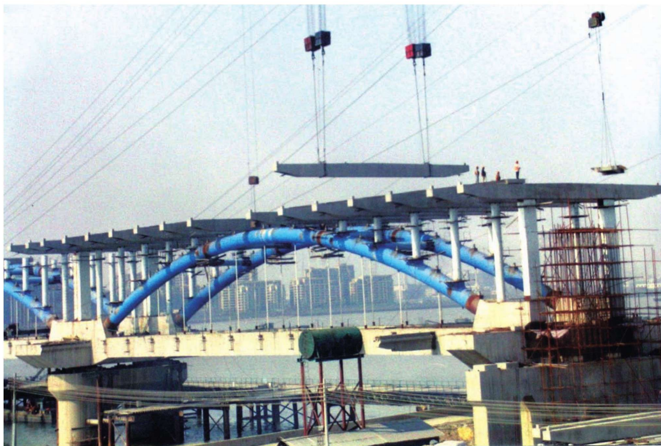
彩图22 安装85m跨拱上横梁
