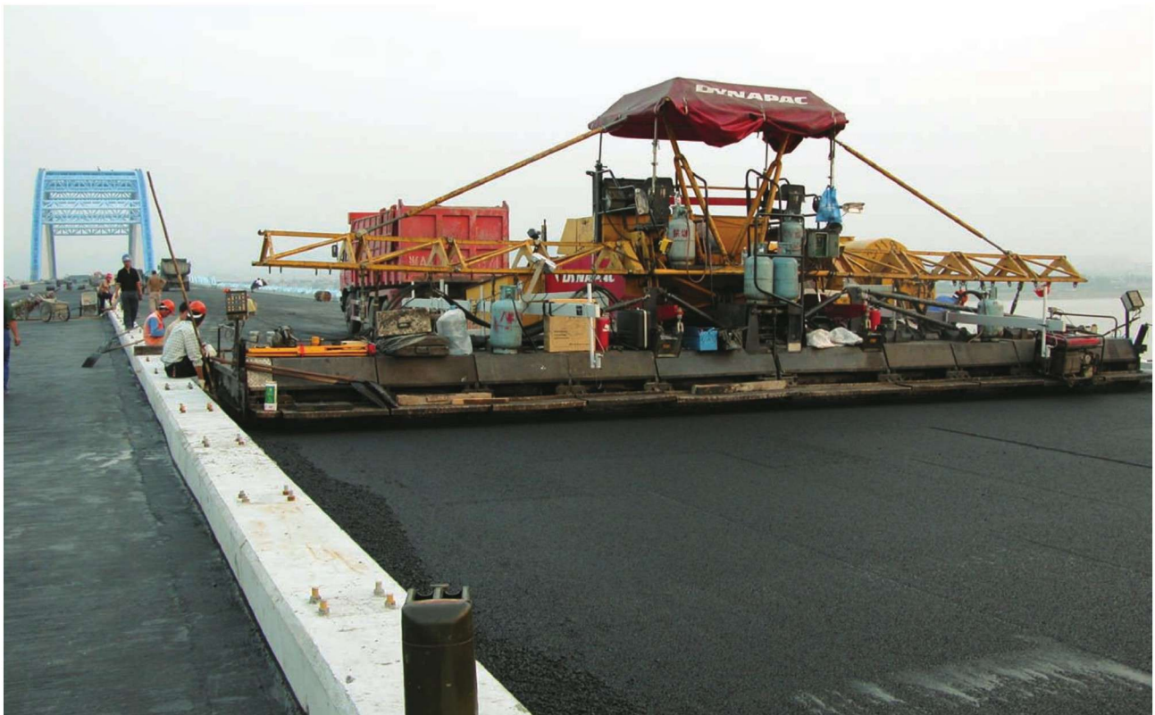
彩图35 桥面铺装沥青
