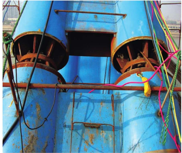
彩图27 190m跨拱肋临时连接
