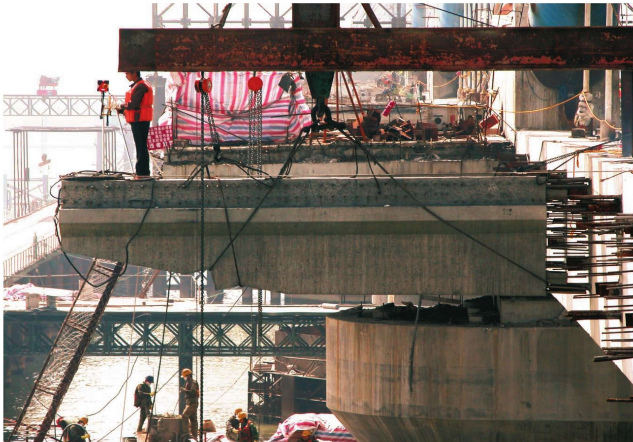
彩图23 安装85m跨下层悬臂横梁
