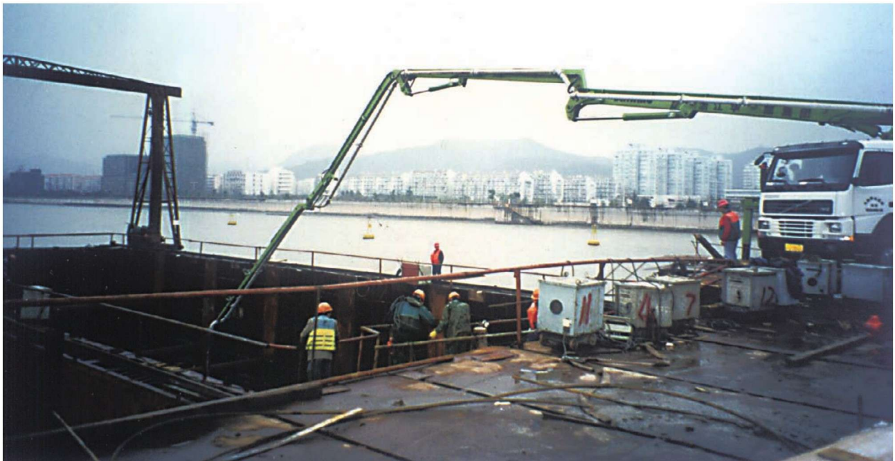
彩图6 钢围堰混凝土封底
