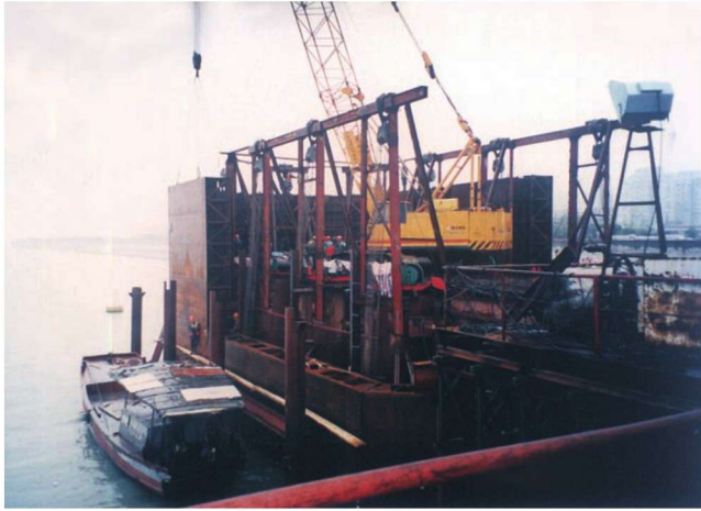
彩图4 施工钢围堰
