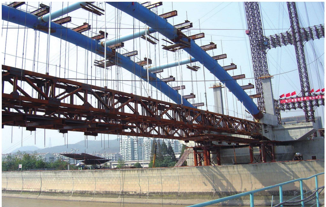
彩图20 施工85m跨系梁劲性骨
