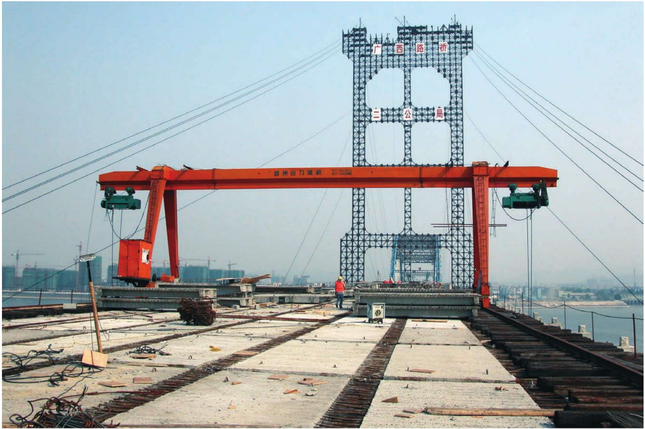
彩图34 桁车吊装桥面板
