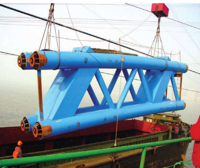
彩图25 起吊190m跨拱肋节段
