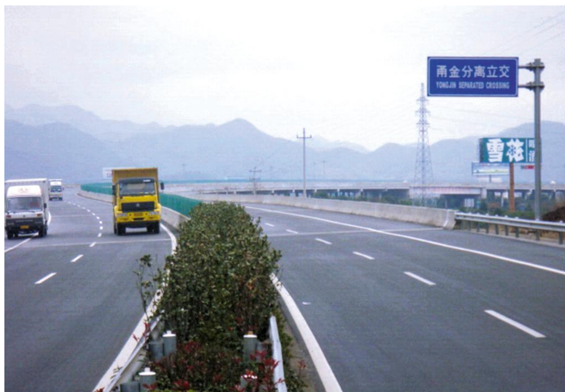
甬金高速公路分离立交桥
