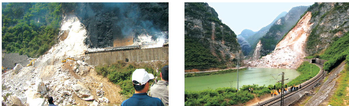
图 1.16 5·12 地震造成宝成铁路 109 隧道塌方并堵塞嘉陵江形成堰塞湖
