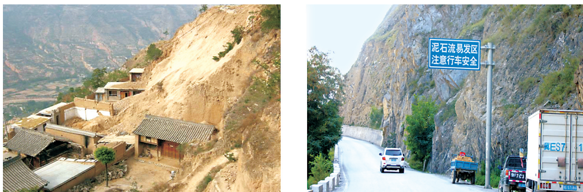
图 1.7 陇南许多傍山房屋和山区公路易受到自然灾害危害或威胁
