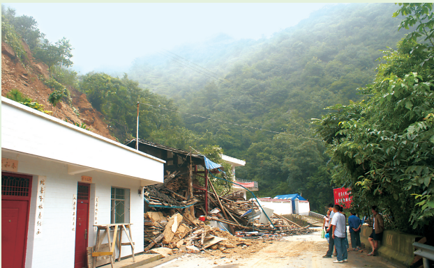
图 1.15 文县 7·27 地震引发碧口镇山体滑坡危及民房
