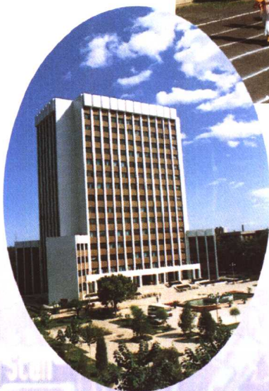
设施齐全、设备先进的教学主楼
