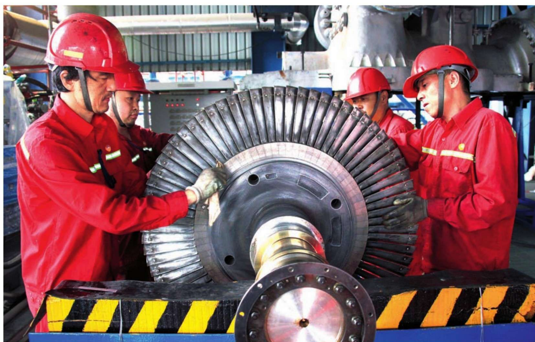
维修人员在精心检修设备
