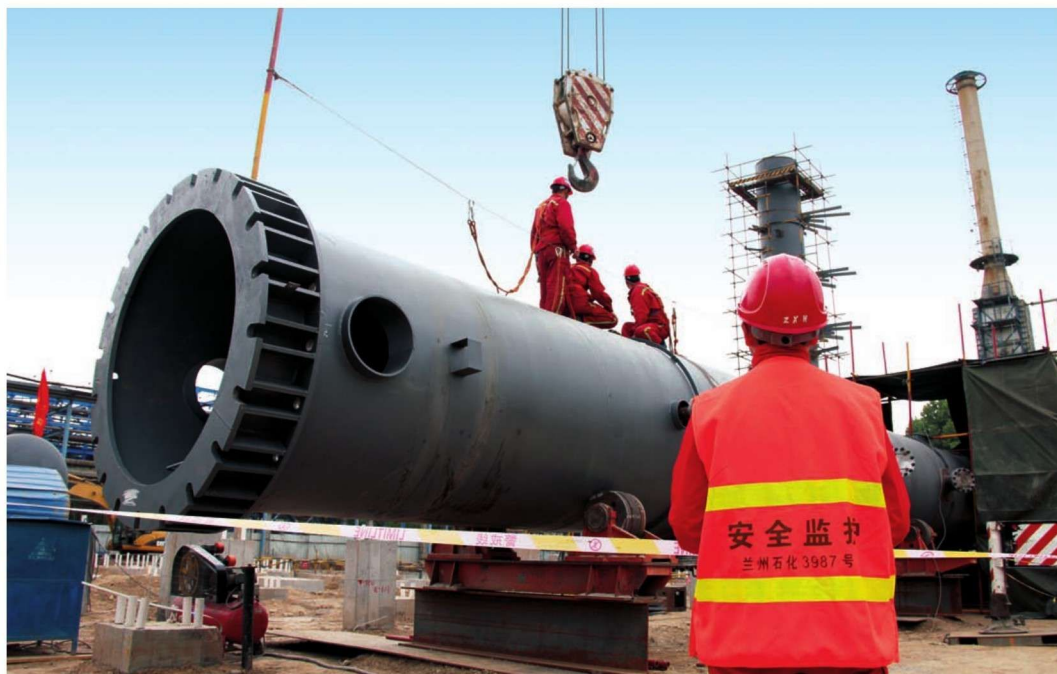
安全监护人员现场监督大型设备吊装
