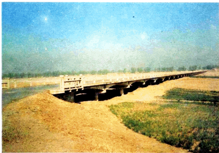
潜龙河漫水桥宋村大桥。
