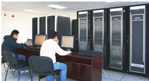
图1-4 电力系统运行仿真及安全监控实验室
