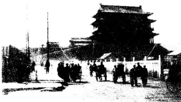
正阳门瓮城本城正阳门内城盘街左侧
