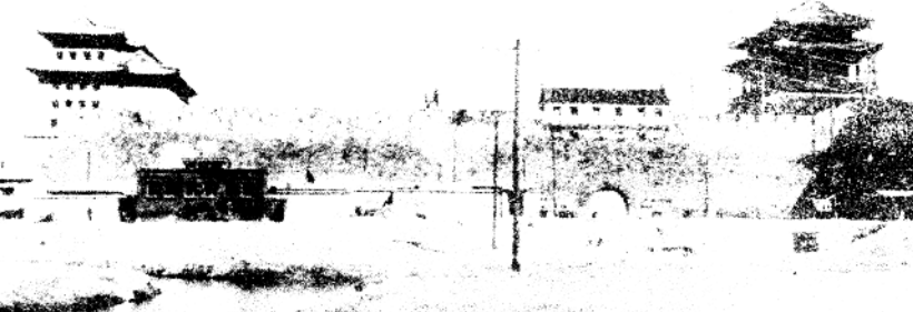
旧日西直门外，右城门楼， 左箭楼
