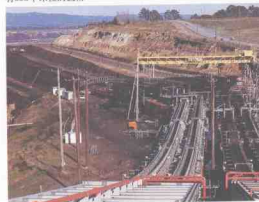
每小时8500吨的输煤装置
