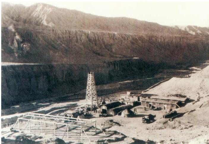
正在钻进中的“老一井”。1939 年 3 月 23 日由孙健初确定的第一口井开始人工挖掘，27 日挖至 23 米时出油一吨多，5 月 6 日改为顿钻钻进，8 月 11 日钻至 115.51 米时发现 K 层，日产原油 27 吨。由此，揭开了开发建设老君庙油田的序幕。
