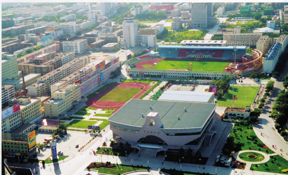
1998年8月竣工的宁夏体育馆
