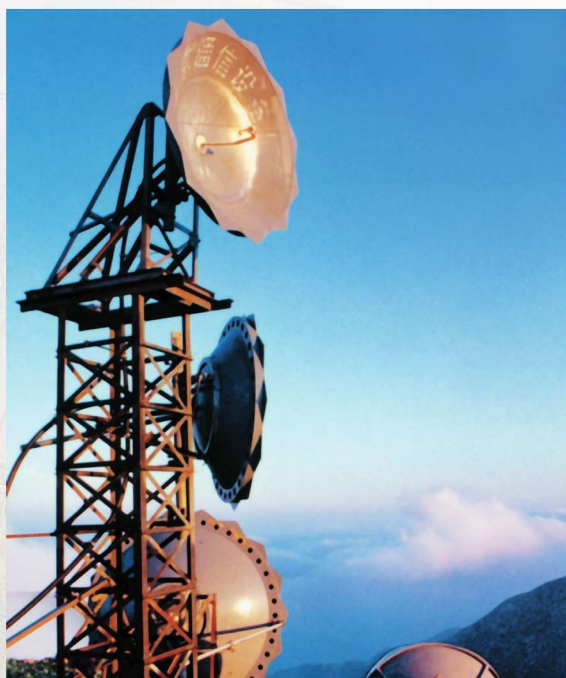
1992年建成的银兰960路微波干线261站
