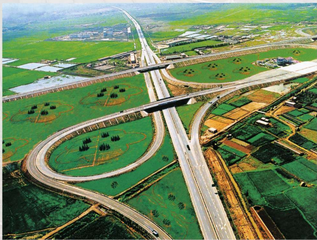
宁夏第一条高速公路——姚叶高速公路于1997年4月28日开工，2000年6月30日全线通车
