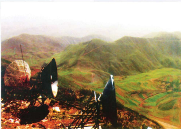
1992年建成的区内二级微波干线六盘山接转站
