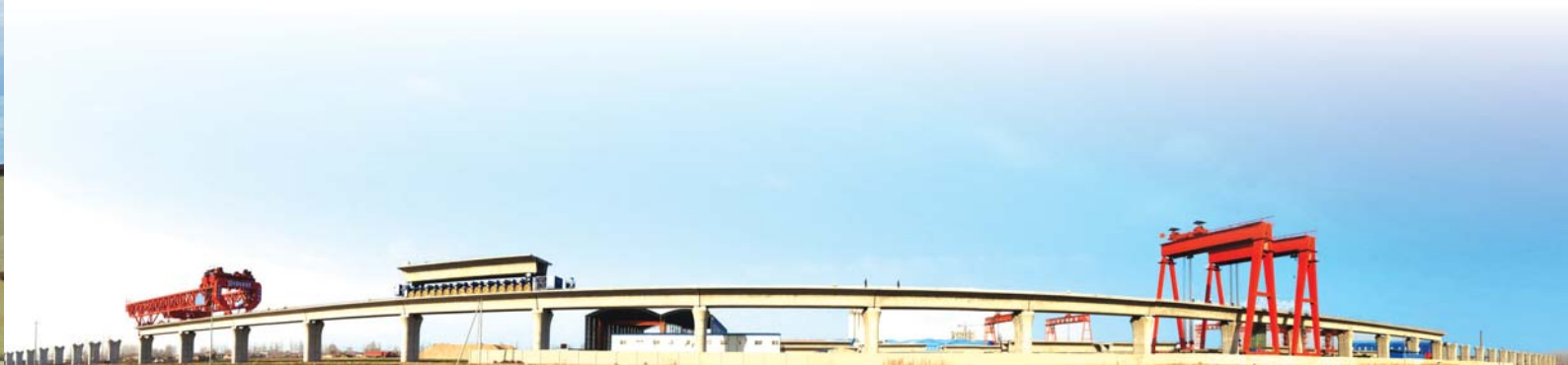
2014年10月26日，建设中的石济高铁辛集段，图为市区西南部施工现场（陈小路摄）
