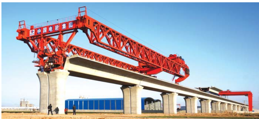
2014年12月3日，建设中的石济高铁辛集段，图为田家庄村北部施工现场（陈小路摄）
