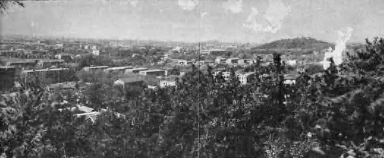
▲九华山南居民区
