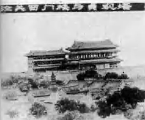
潼关西城门楼
