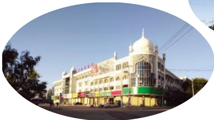
外立面改造后的金城商厦
