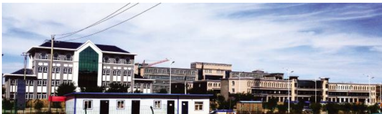
建设中的海原县人民医院
