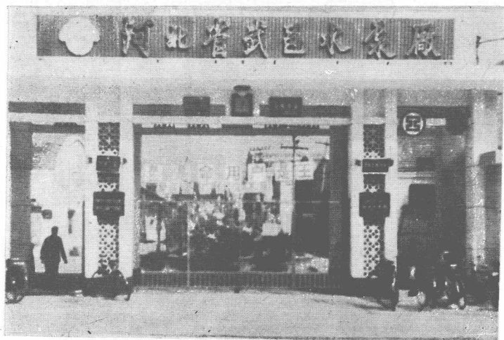
△武邑县水泵厂门口
