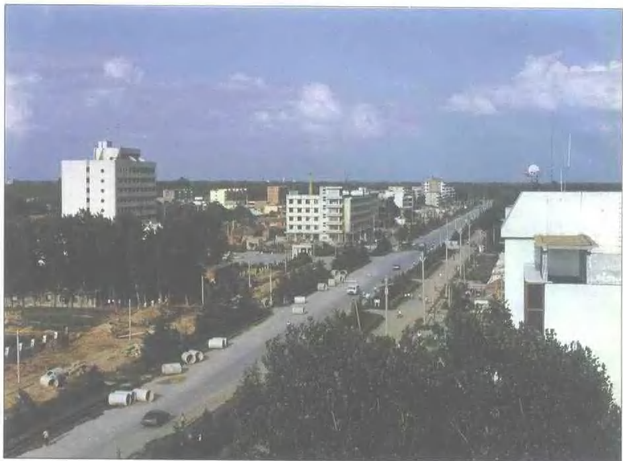
建设中的永城新城
