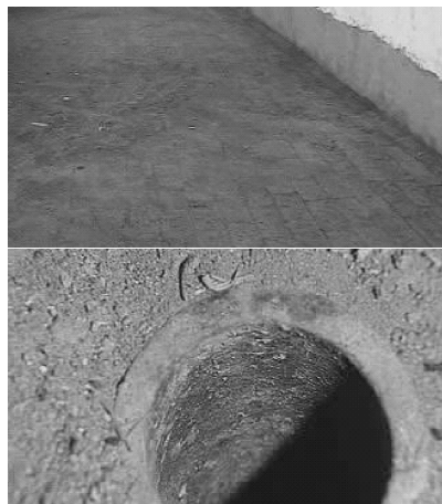
图 1-7 鹌舍地面及排水
