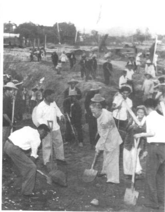
刘少奇同志在北京石景山钢铁厂扩建工 地上参加劳动(1958年7月)
