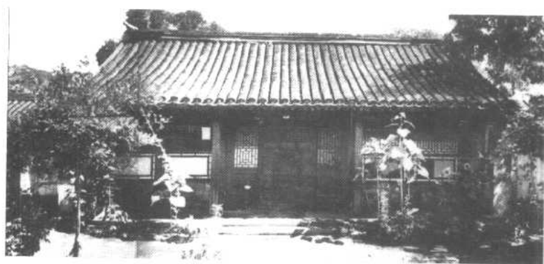
中共北方局地下电台旧址— 北平西单粉子胡同二十号
