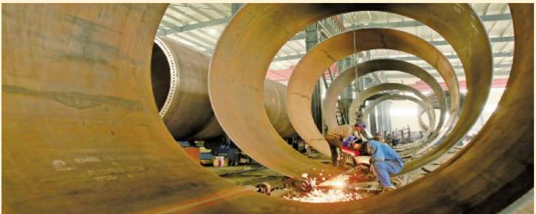
山泰钢结构风机塔筒加工
