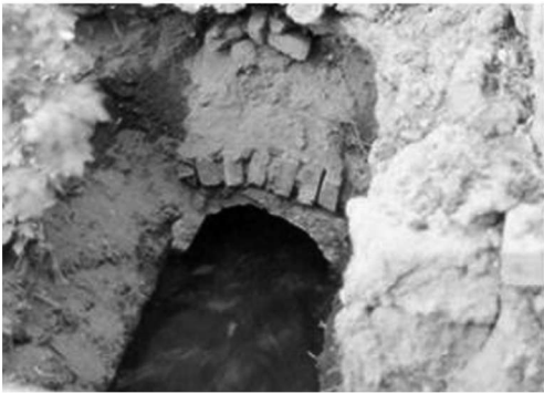
(c) 暗渠出口
