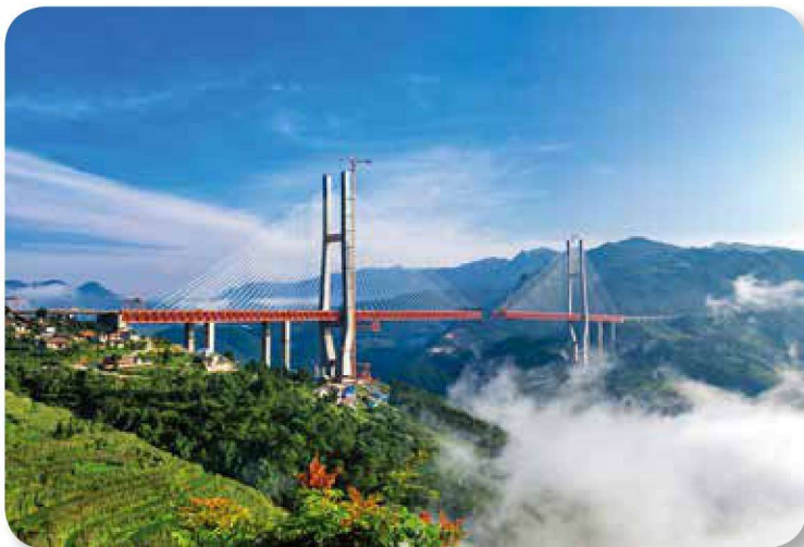
• 尼珠河特大桥
