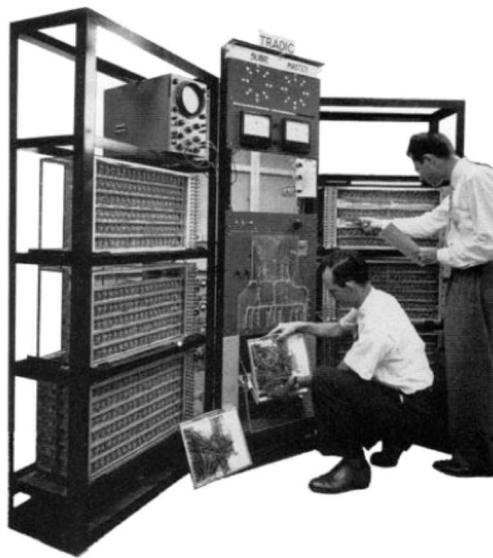
图 1-2 第一台晶体管计算机
