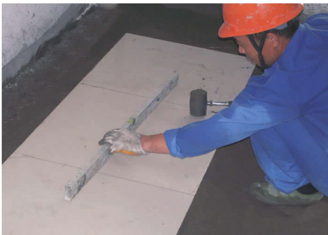
图1-2 地面地砖试铺
