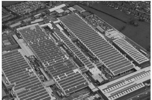
(b) 光伏屋顶发电站
