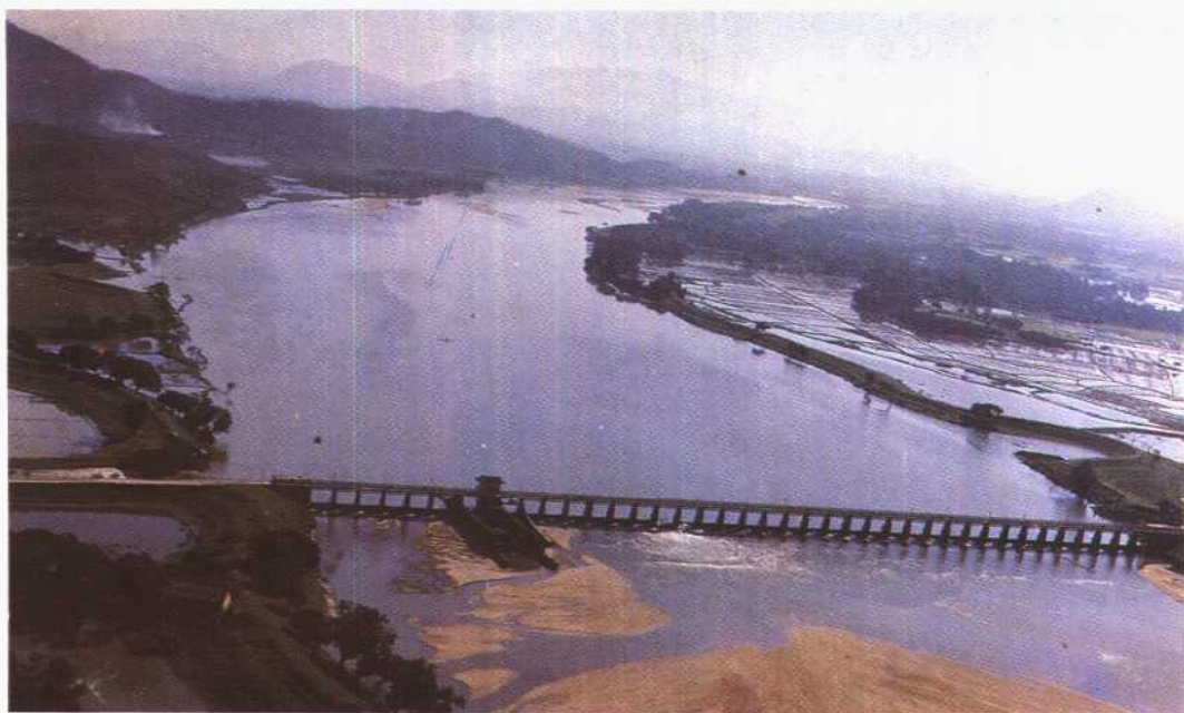
黄龙带水库大坝溢洪道
