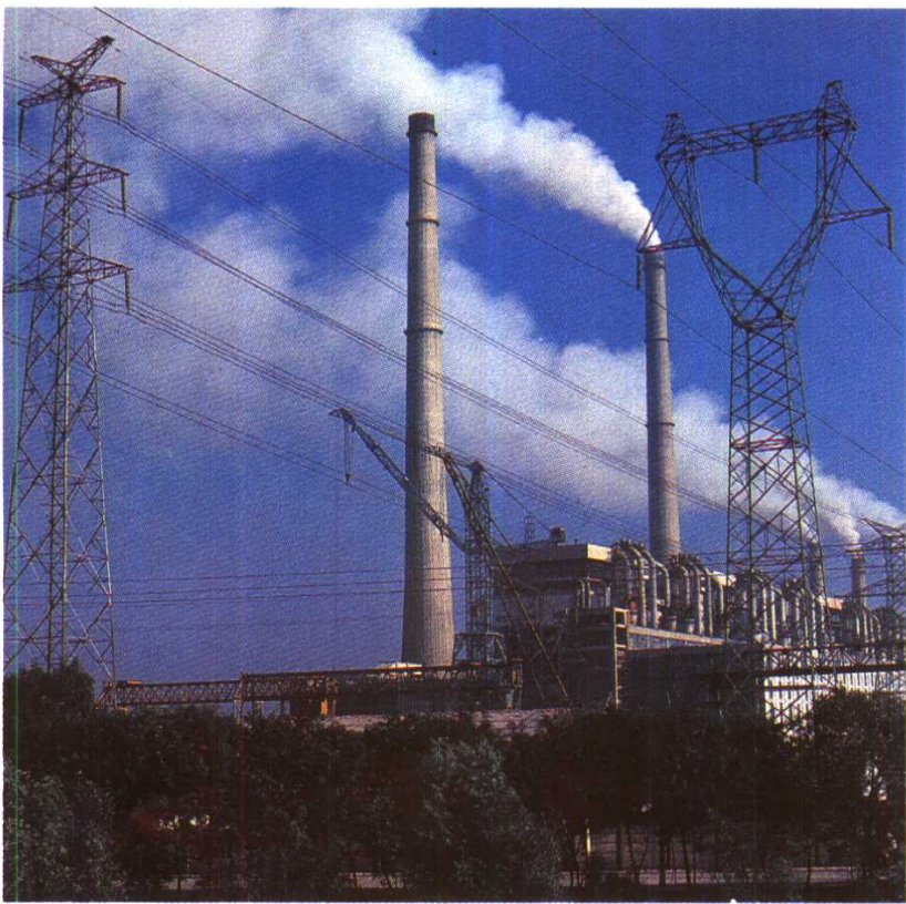
全国最大的火力发电厂——谏壁发电厂
