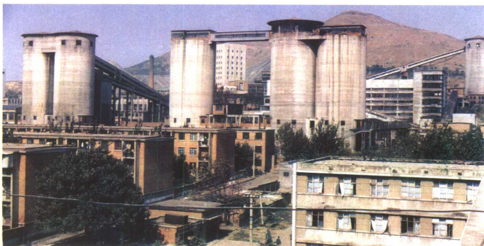
平顶山矿务局八矿
