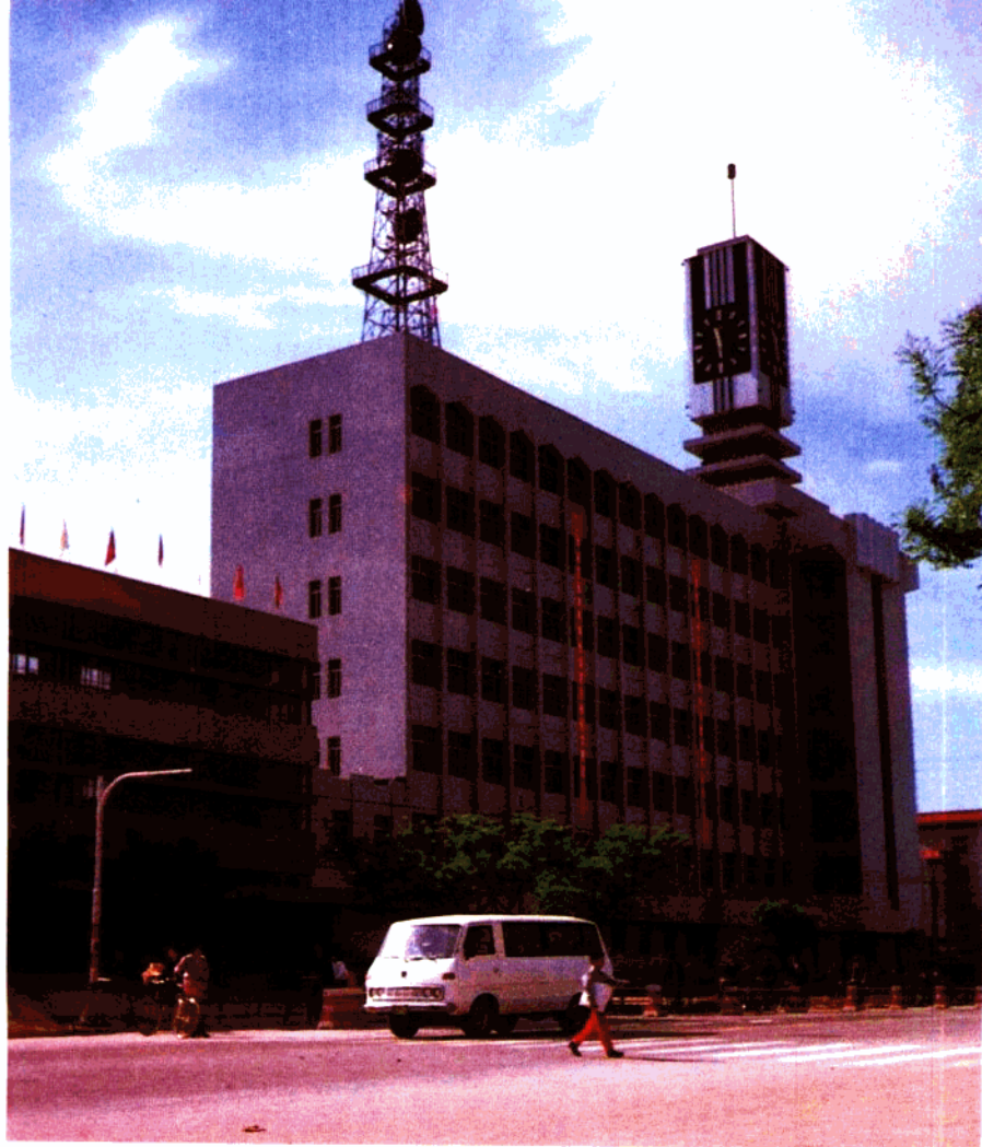
新建沧州市邮电大楼
