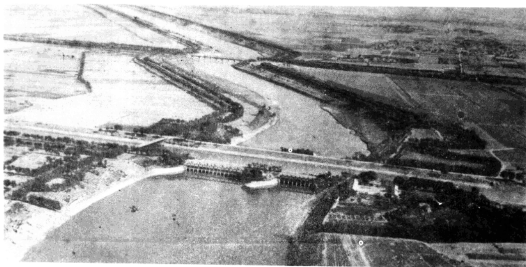
1965年7月建成的肖楼南排河穿运(河)倒虹吸工程
