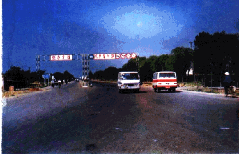
沧州市至吴桥段专用公路 一九八六年改建成功的京福公路
