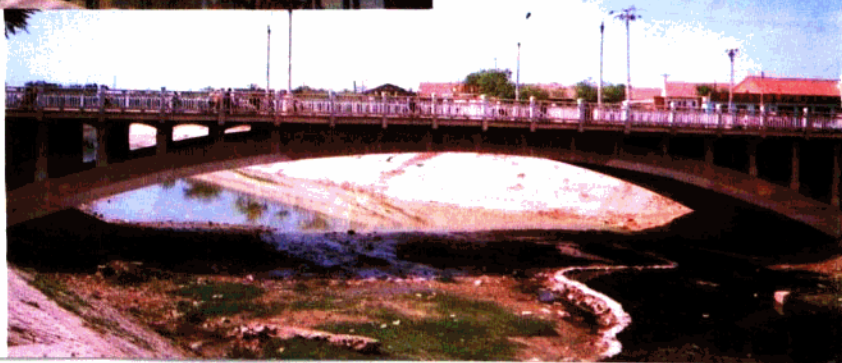
沧州市最大的单孔桥 —— 解放桥
